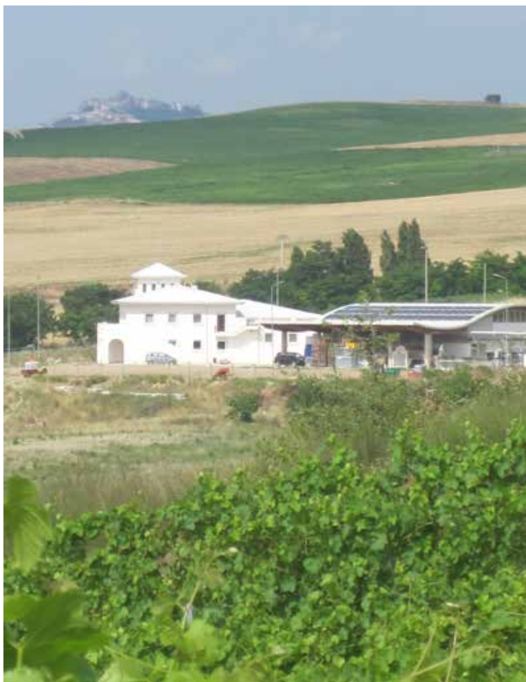
Die neue Cantina Alovini, im Hintergrund die mittelalterliche Hügelsstadt Acerenza
